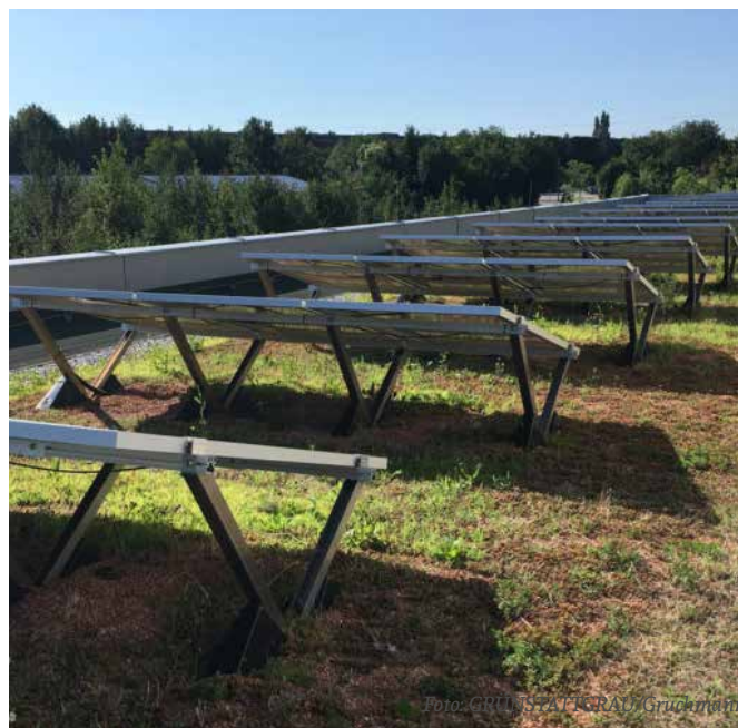
Kombination Photovoltaik mit Dachbegrünung.
