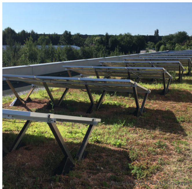
Kombination Photovoltaik mit Dachbegrünung.
